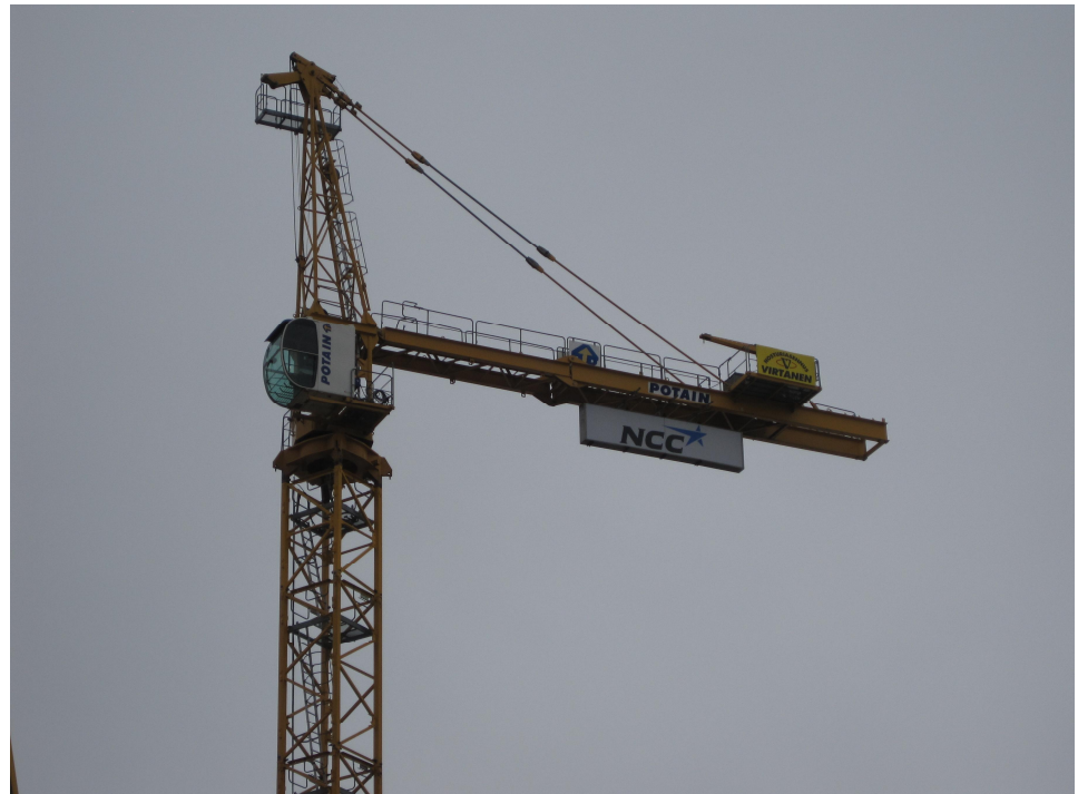
Torninosturin pystytys käynnissä.
