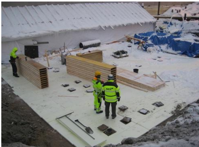
Linjojen 5-10 pohjalaatan valmistelevat työt aloitettu.
