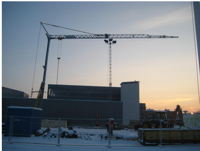
Perustusvaiheen nosturi on asennettu työmaalle.
